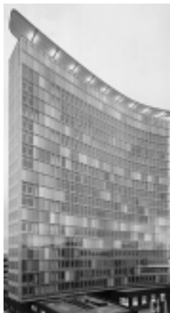
Beispiel für ökologisches Bauen: Niedrigenergiehaus der GSW in Berlin-Kreuzberg
