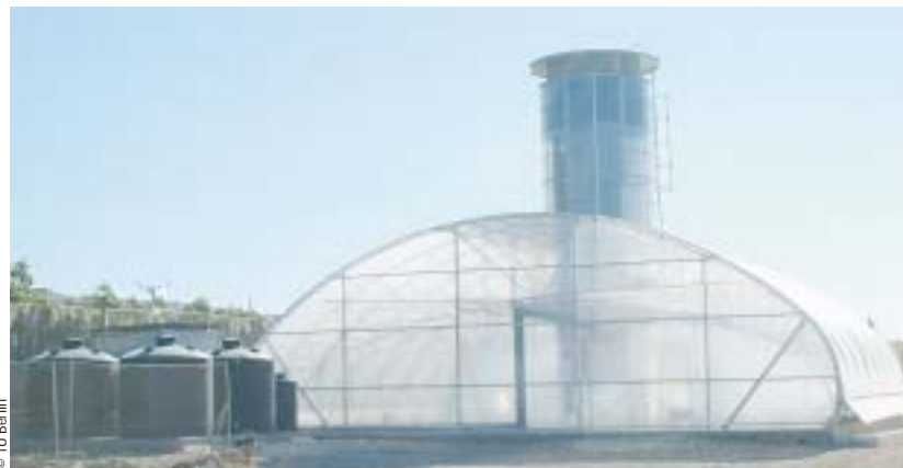
Das geschlossene Gewächshaus in Almeria mit Kühlschacht zur Rückgewinnung von Wasser
