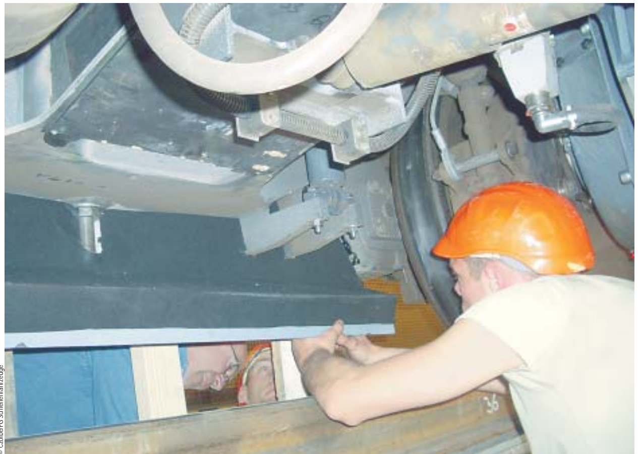
Am Triebdrehgestell eines S-Bahn-Zuges wird eine Schallschürze montiert, die die Fahrgeräusche zu vermindern hilft
