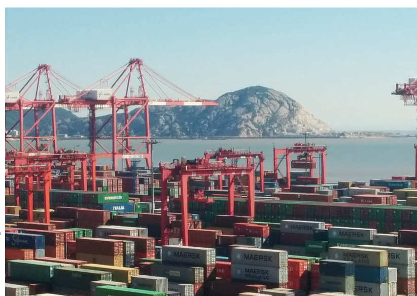
Tiefwasserhafen Yangshan nahe Shanghai im Ostchinesischen Meer
