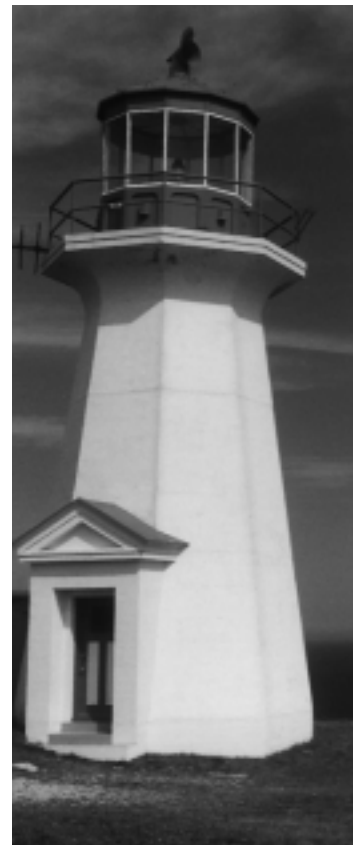
Wie ein Leuchtturm soll das Forschungsprojekt wegweisend für weitere Vorhaben sein
