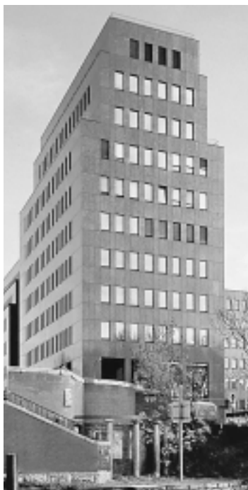
Der Firmensitz von Teles in der Dovestraße
