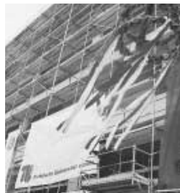
Richtfest beim Bau der Uni-Bibliothek im Juli
