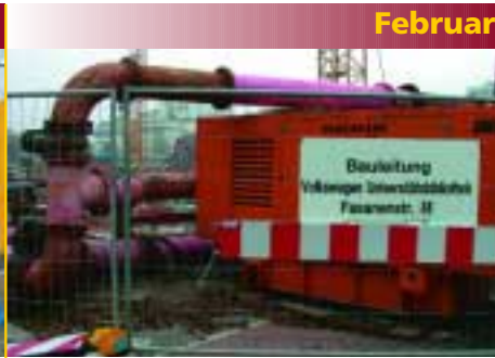
Februar Die Volkswagen-Universitätsbibliothek an der Hertzallee wird endlich gebaut. Über das Jahr tummeln sich bereits Kräne, Betonmischer und Stahlträger auf der Baustelle
