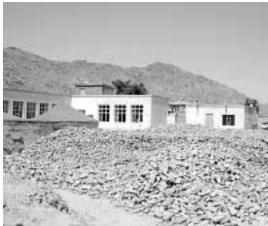
Der Bauplatz der Soria-Schule ist derzeit noch ein Trümmerfeld
