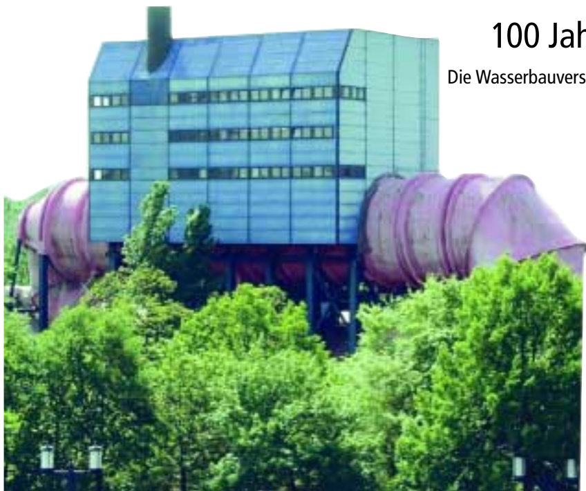
Der große Tank für den Wasserumlauf auf der Schleuseninsel ist den Berlinern besser bekannt als „Rosa Röhre“
