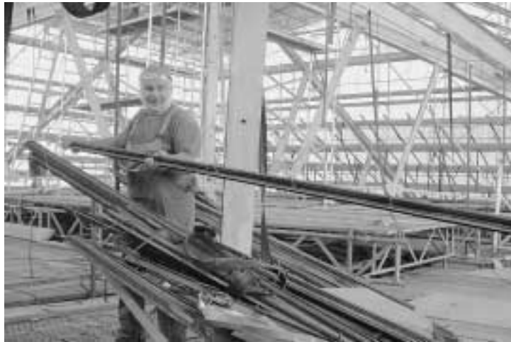
Arbeitsplatz in luftiger Höhe: Das Glasdach in der Lichthofkuppel wird erneuert
