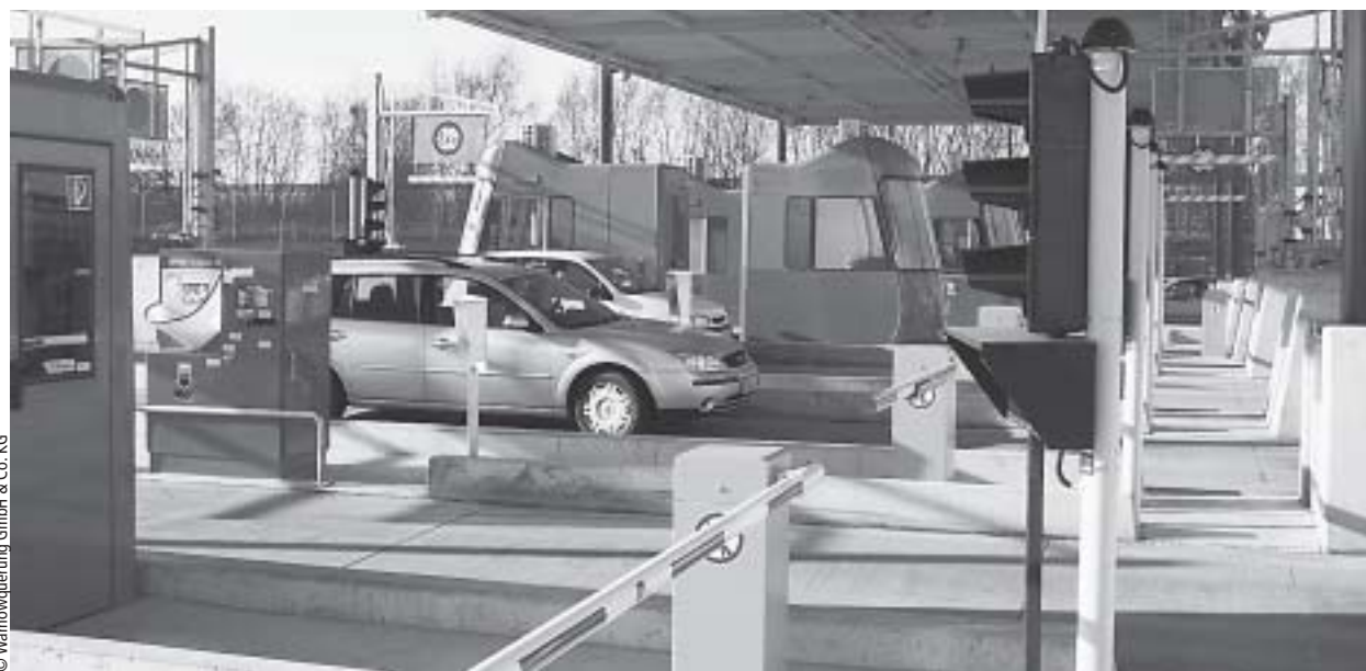
In Rostock wurde der erste nach dem Public-Private-Partnership-Prinzip errichtete Tunnel in Betrieb genommen – die Warnow-Querung. Eine Mautgebühr soll die privaten Investitionen refinanzieren
