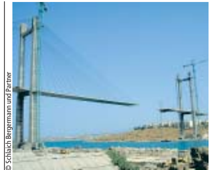
Griechische Eviros-Brücke, fertig gestellt 1992
