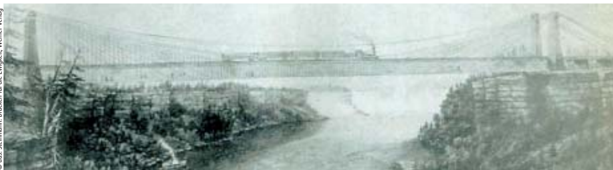
1855 wurde die Doppelstockbrücke über den Niagara eingeweiht, die erste Hängebrücke der Welt, die Eisenbahnüberquerung und normalen Straßenverkehr zuließ
