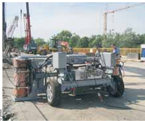
100 Meter Draht pro Stunde magnetisiert das System im Beton
