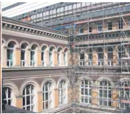
Hand angelegt: Arbeit im Innenhof, eingebaute Stahlstützen im Erdgeschoss des Hauptgebäudes, Gerüstbau für vier neue Geschosse
