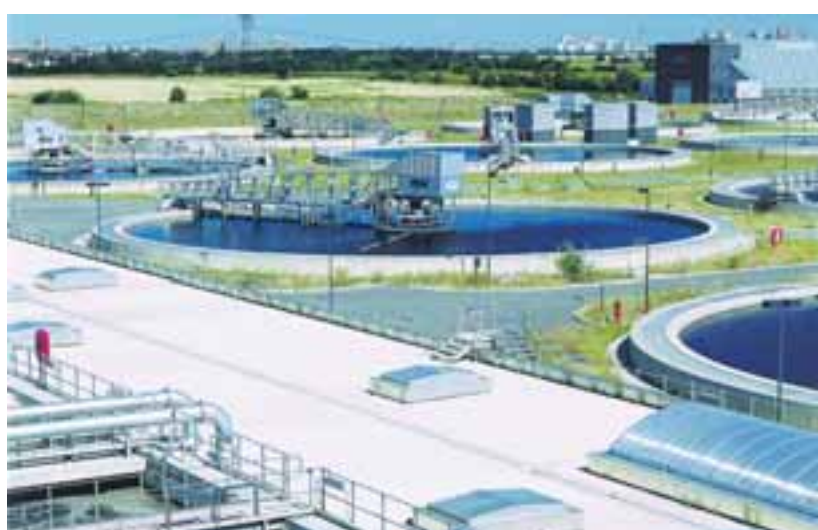
Außenanlage des Klärwerks Waßmannsdorf bei Berlin
