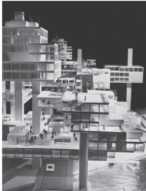
Metastadt, System in vorgefertigter Stahlblettbauweise zur Herstellung multifunktionaler und variabler Gebäudeagglomerationen, 1965, Architekt: Richard J. Dietrich
